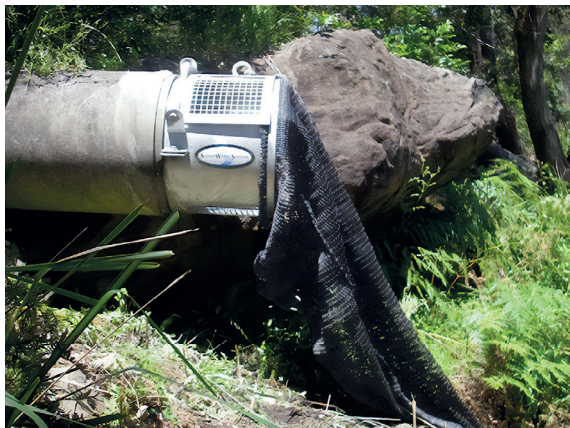
Figura 2: Red que recubre la tubería del alcantarillado
